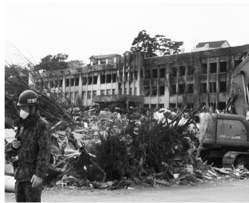
写真4 火災で全焼した石巻市内の小学校
