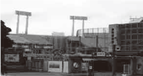
写真4 解体工事中の旧国立競技場(2015.3.20)
