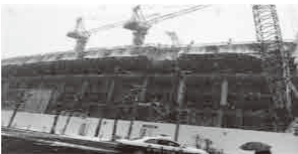
写真6 新国立競技場建設(2018.1.22)
